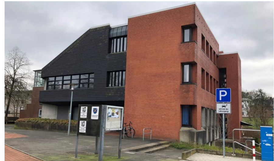
Abbildung 25: Amtsgebäude Boostedt-Rickling (CIMA 2022)
