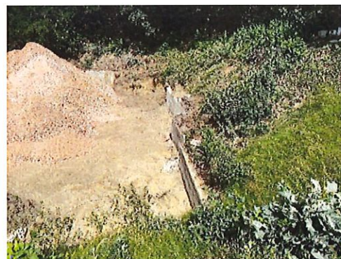
Abbildung 4 Nördliche Geländekante bei Abbruch, Juli 2020
